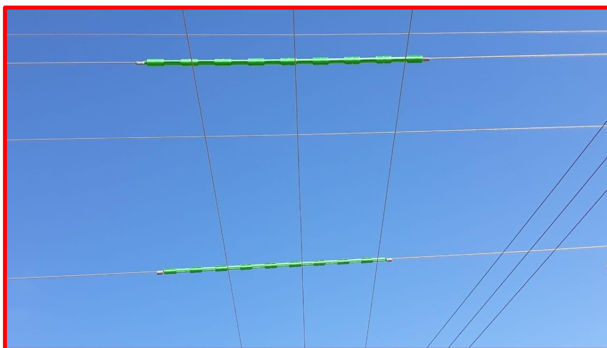
تصویر شماره ۵: روکش عایقی این شرکت نصب شده بر روی خطوط ۶۶ کیلو ولت استان لرستان، عبوری از روی شبکه ۲۰ کیلو ولت
