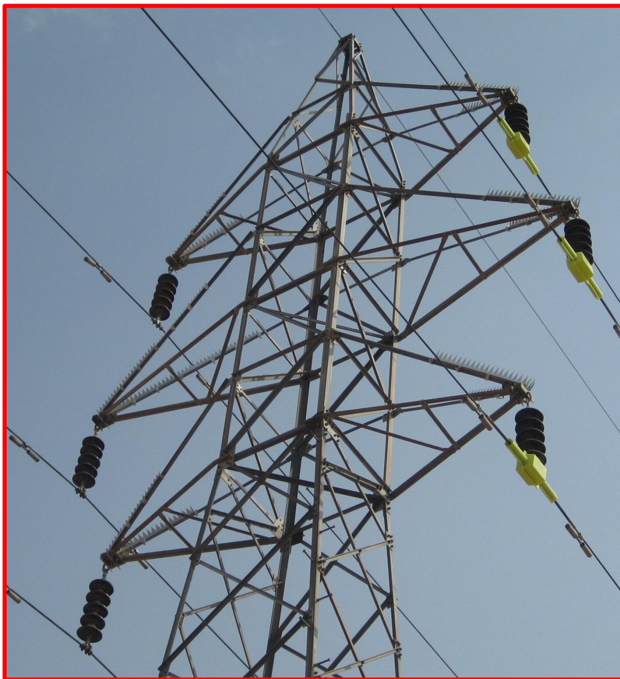
تصویر شماره ۲: روکش عایقی نصب شده بر روی خطوط ۶۶ کیلو ولت استان فارس
